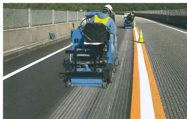
発注元：石川県中能登土木事務所 施工地：のと里山海道 用途：凍結防止・スリップ抑制 施工タイプ：アスファルト縦 幅 9mm×60mm×6mm
