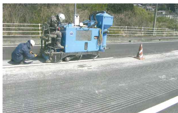
発注元：愛媛県 施工地：愛媛県北宇和郡松野町 用途：凍結防止・スリップ防止 施工タイプ：アスファルト縦 幅 9mm×60mm×6mm
