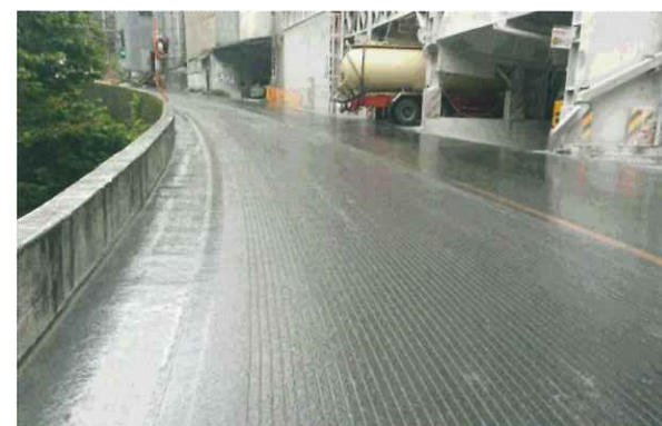
発注元：埼玉県 施工地：埼玉県横瀬町 用途：スリップ抑制・凍結防止 施工タイプ：アスファルト縦 幅 9mm×60mm×6mm
