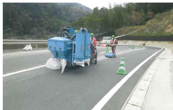
発注者：大分県玖珠土木事務所 施工地：大分県玖珠郡玖珠町大字山浦 用途：凍結防止・スリップ抑制 施工タイプ：アスファルト縦 幅 9mm×60mm×6mm
