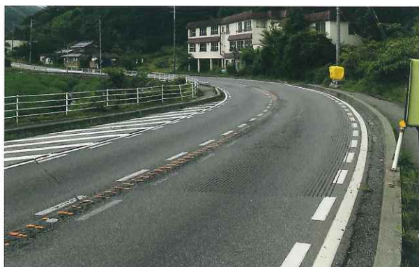
発注元：長野県佐久建設事務所 施工地：長野県佐久市 用途：事故抑制・スリップ防止 施工タイプ：アスファルト縦 幅 9mm×60mm×6mm
