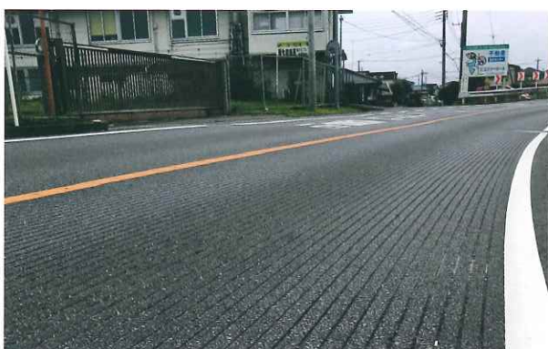
発注元：栃木県 施工地：栃木県鹿沼市 用途：スリップ抑制・凍結防止 施工タイプ：アスファルト縦 幅 9mm×60mm×6mm
