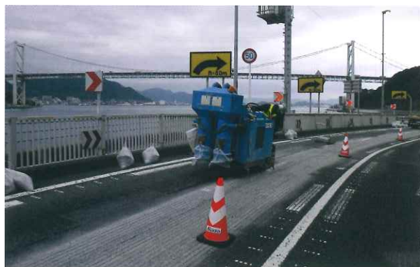
発注元：山口河川国道事務所 施工地：山口県下関市壇之浦町 用途：スリップ防止 施工タイプ：アスファルト縦 幅 9mm×60mm×6mm
