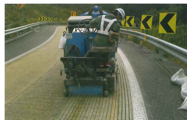
発注元：ネクスコメンテナンス 施工地：島根県出雲市(斐川インター) 用途：スリップ抑制・凍結防止 施工タイプ：アスファルト縦 幅 9mm×60mm×6mm
