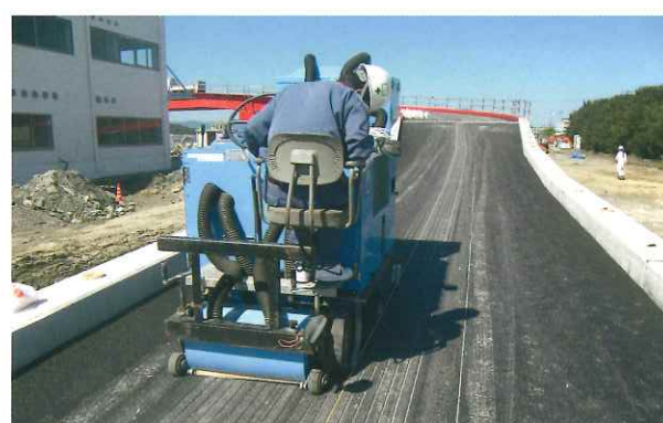
発注元：オーシャン東九フェリー 施工地：徳島県徳島市東沖洲 用途：スリップ防止 施工タイプ：アスファルト縦 幅 9mm×60mm×6mm
