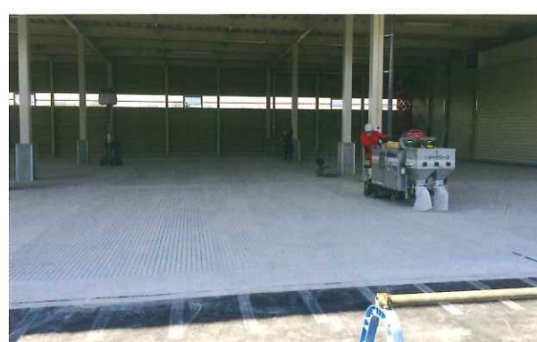
発注元：旭化成重工 施工地：滋賀工場 用途：凍結防止・フォークリフトスリップ抑制 施工タイプ：アスファルト縦 幅 9mm×60mm×6mm
