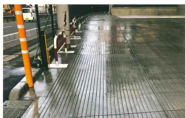
発注元：スーパーヤオコー中之条店 施工地：群馬県吾妻郡中之条町 用途：運搬車両スリップ抑制・凍結防止 施工タイプ：アスファルト縦 幅 9mm×60mm×6mm
