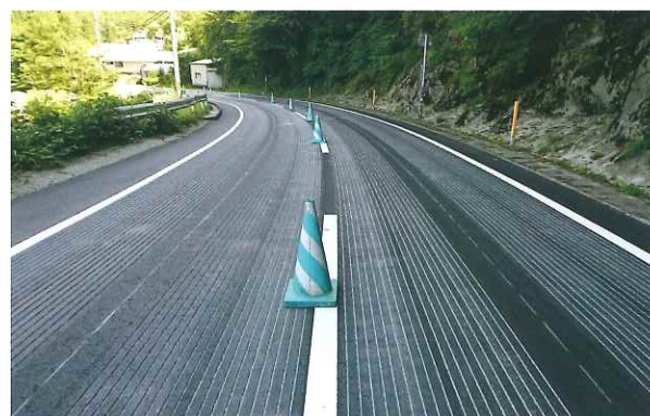
発注元：宮崎県西臼杵支庁 施工地：宮崎県西臼杵郡五ヶ瀬町鞍岡 用途：凍結防止・スリップ抑制 施工タイプ：アスファルト縦 幅 9mm×60mm×6mm
