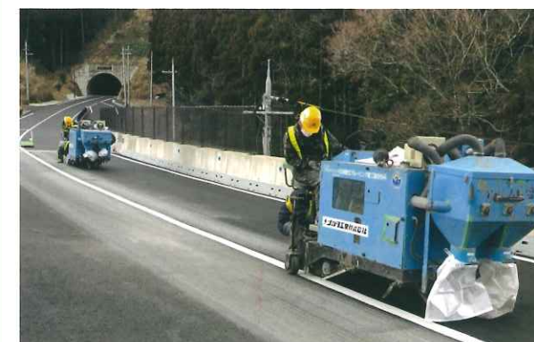
発注元：京都府山城北土木事務所 施工地：京都府綴喜郡宇治田原町地内 用途：凍結防止・スリップ抑制 施工タイプ：アスファルト縦 幅 9mm×60mm×6mm
