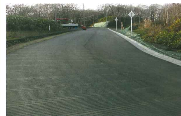
発注元：北海道防衛局 施工地：奥尻島 用途：凍結防止・スリップ抑制 施工タイプ：アスファルト横 幅 9mm×60mm×6mm
