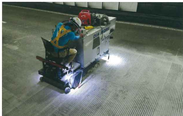
発注元：NEXCO 西日本 施工地：山陽道(姫路) 用途：スリップ抑制 施工タイプ：アスファルト横 幅 9mm×32mm×6mm
