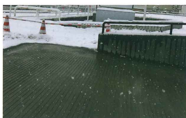
発注元：山形トヨペット東バイパス店 施工地：山形市上山家町字下宿 用途：車輛スリップ防止 施工タイプ：コンクリート横 幅 9mm×60mm×6mm
