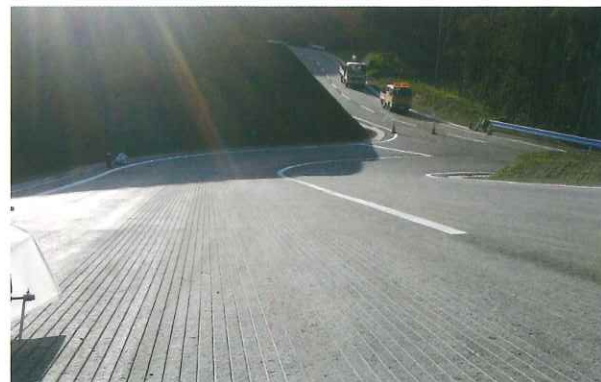
発注元：宮城県 施工地：宮城県東松島市大塩引沢 用途：事故抑制・スリップ防止 施工タイプ：アスファルト縦 幅 9mm×60mm×6mm
