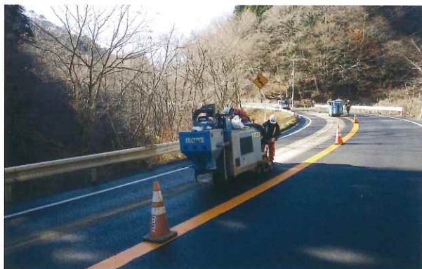
発注元：福島県 施工地：福島県南相馬市原町区大原地内 用途：凍結防止 施工タイプ：アスファルト縦 幅 9mm×60mm×6mm
