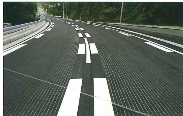
発注元：日向土木事務所 施工地：宮崎県東臼杵郡美郷町水清谷 国道388号 用途：スリップ防止 施工タイプ：アスファルト縦 幅 9mm×60mm×6mm
