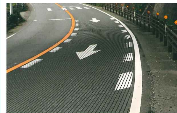
発注元：群馬県 施工地：群馬県安中市松井田 碓氷峠 用途：スリップ抑制・凍結防止 施工タイプ：アスファルト縦 幅 9mm×60mm×6mm
