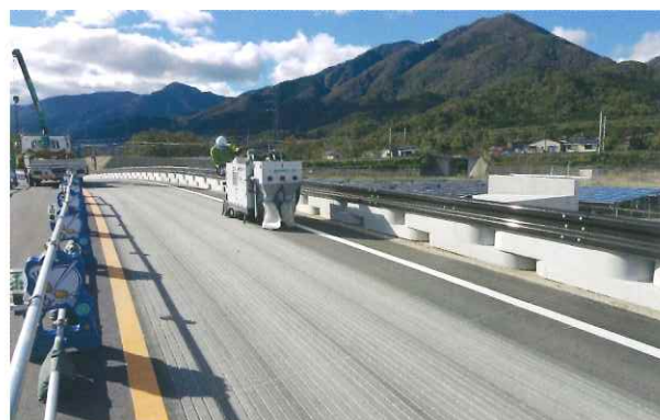
発注元：近畿地方整備局滋賀国道事務所 施工地：滋賀県大津市R161 用途：坂道スリップ抑制・凍結防止 施工タイプ：アスファルト縦 幅 9mm×60mm×6mm
