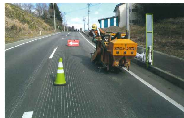
発注元：一関市役所 施工地：岩手県一関市藤沢町増沢地内 用途：スリップ抑制・凍結防止 施工タイプ：アスファルト縦 幅 9mm×60mm×6mm
