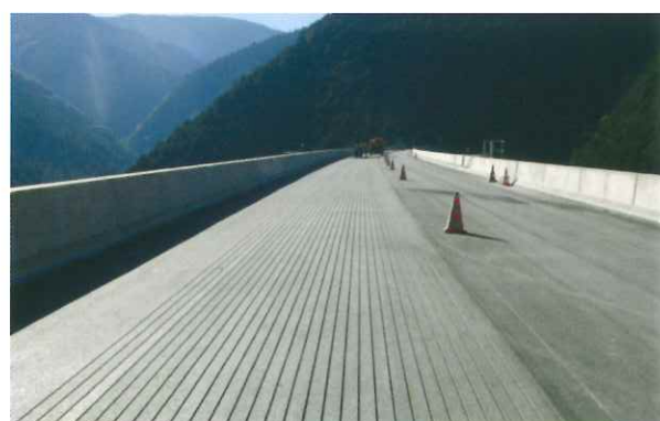
発注元：NEXCO中日本 施工地：新清水JCT～富沢IC 用途：覆道出入口スベリ防止 施工タイプ：アスファルト縦 幅 12mm×100mm×18mm
