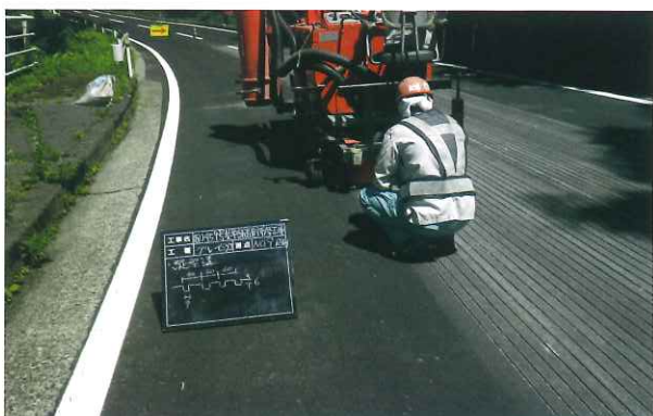
発注元：新潟県新潟地域振興局 施工地：新潟県阿賀町 用途：凍結防止・スリップ抑制 施工タイプ：アスファルト縦 幅 9mm×60mm×6mm
